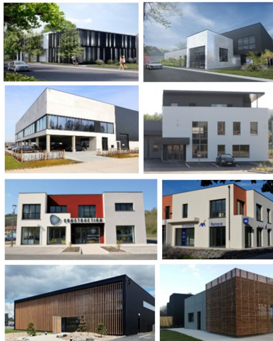
Exemples de bâtiments utilisant 2 matériaux et 2 coloris
